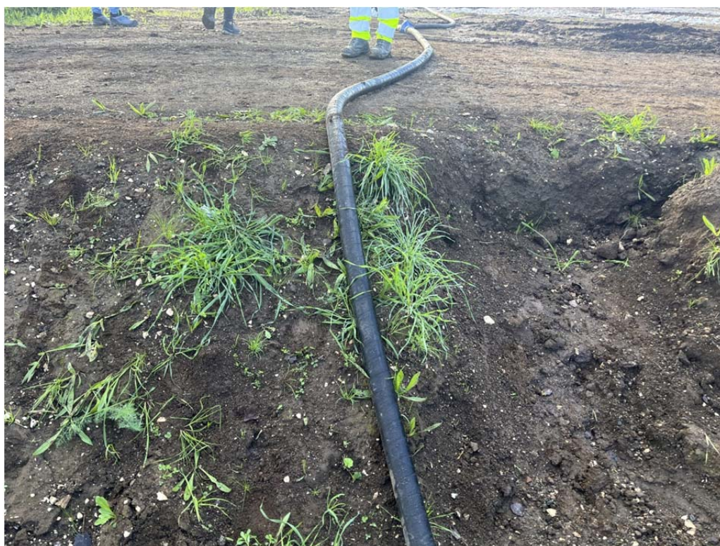
Tubazione per allontanare l'acqua emunta durante la prova di pozzo
